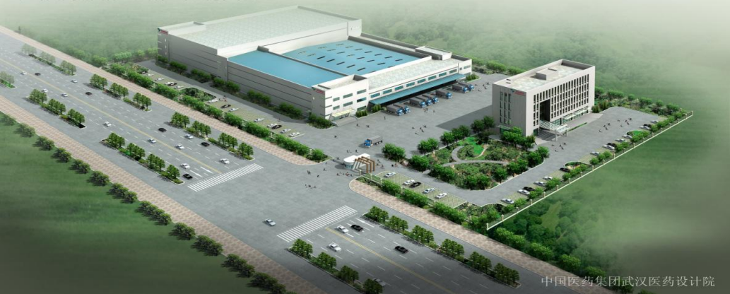
国药控股安徽有限公司物流中心建设项目
